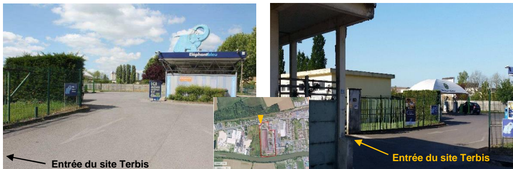
Figure 14-6 : Vue du site Terbis depuis la rue Pasteur
