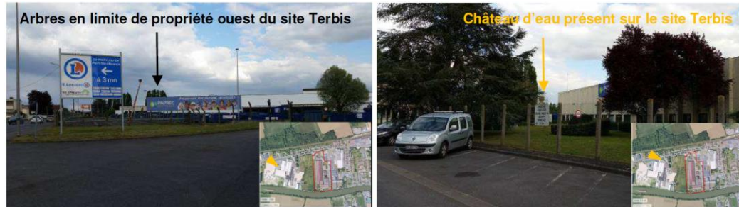
Figure 14-7 : Vue du site Terbis depuis la société Paprec
