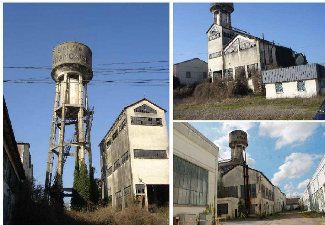
Figure 14-11 : Château d'eau implanté sur le site
